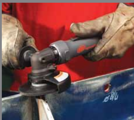
Rimozione di materiale
